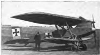
Abbildung 23. Junkers' Infanterie-Flugzeug, Chromnickelstahlpanzerung.
