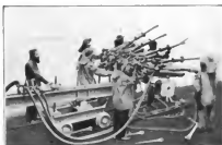
Abbild. 28. Stoßbohrmaschinen auf Bohrwagen.
