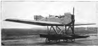
Abbildung 31. Junkers-Flugzeug, Marine C.I, 185 P. S. mit Duraluminium-Schwimmern.
