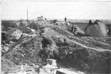
Abbildung 25. Geschößpanzer, durch Volltreffer einer 42-cm-Granate zerstört.
